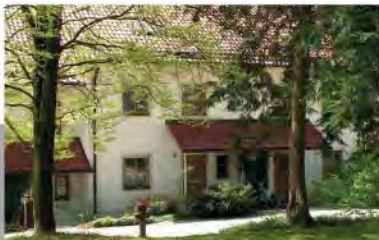
Objekt E02 – Leuchtenbergweg 4b
